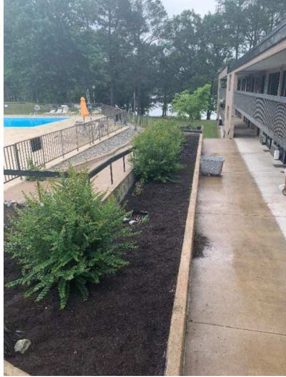
74) Pool Area Drainage
