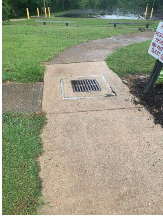
76) Pool Area Drainage
