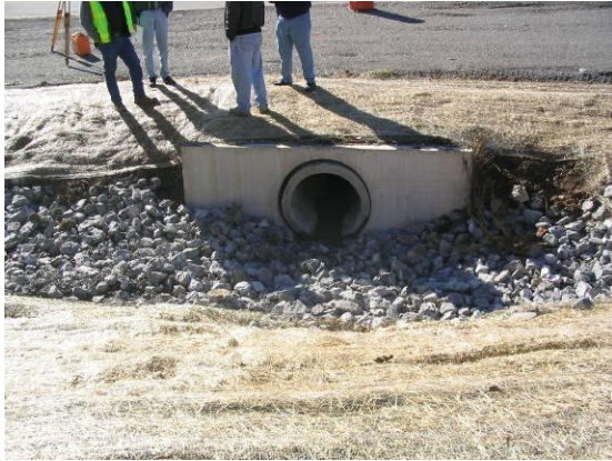
Riprap Outlet Protection
