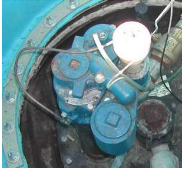
تركيب صحيح لأنبوب فتحة كاشف تسربات الخطوط الميكانيكي في المضخة المغمورة FE Petro (منفذ الخزان السفلي).
