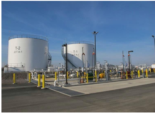
مثال مزرعة الوقود مع الخزانات الأرضية والخزانات فوق الأرض
