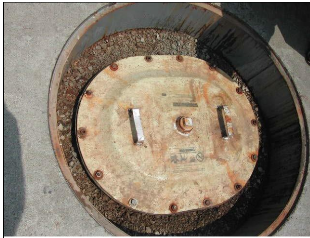
حوض بيضاوي الشكل أعلى خزان البلاستيك المعزز بالألياف الزجاجية (FRP)
