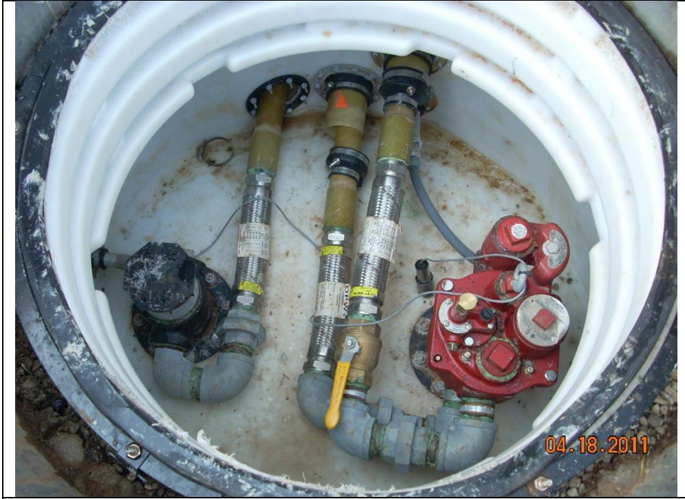
نظام مولدات الطوارئ المضغوطة مجهزة بمستشعر بيئي.
