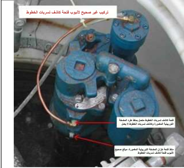
تركيب غير صحيح لأنبوب فتحة كاشف تسربات الخطوط الميكانيكي (منفذ الطرد العلوي)؛ كاشف تسربات الخطوط الميكانيكي لا يعمل.
