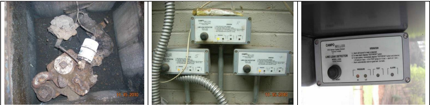
كاشف تسربات خطوط إلكتروني بمحول إشارة ضغط Campo/Miller LS-300
