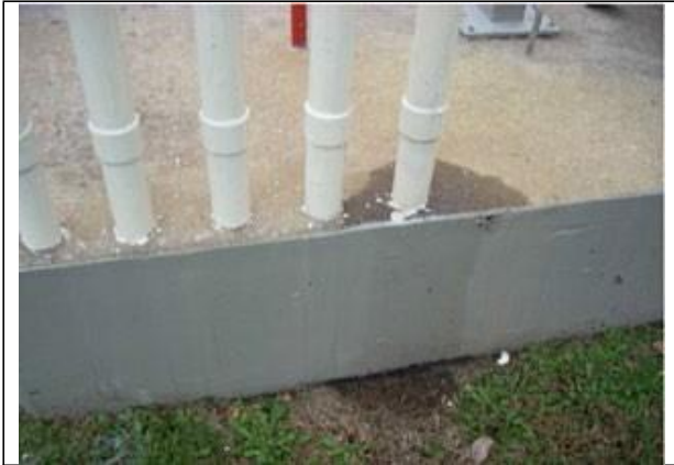
قد يتسبب الخزان عند تعبئته بشكل زائد في حدوث تسرب من أنبوب الفتحة
