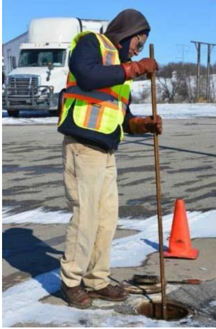
يتم قياس مستوى السائل في الخزان في بداية فترة محددة ونهايتها.
