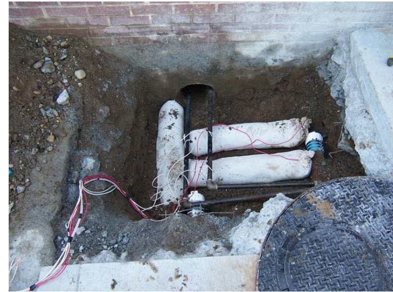
الأقطاب الموجبة في أكياس متصلة بالأنابيب المعدنية
