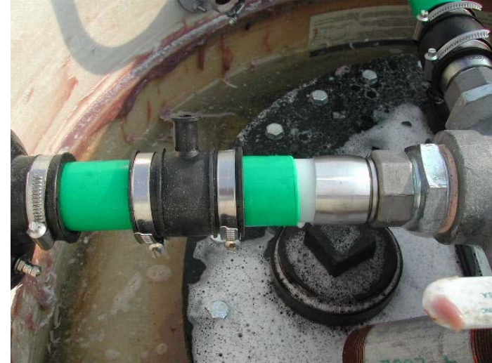
أنابيب مزدوجة الجدار مع وصلات اختبار
