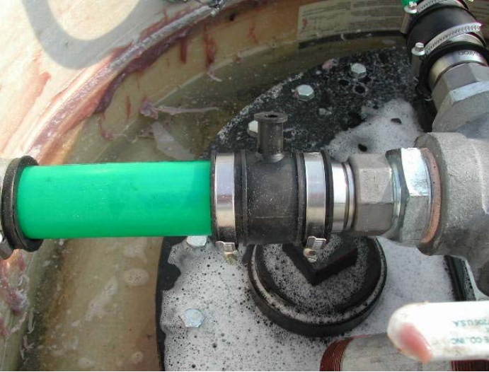
أنابيب مزدوجة الجدار مع وصلات اختبار
