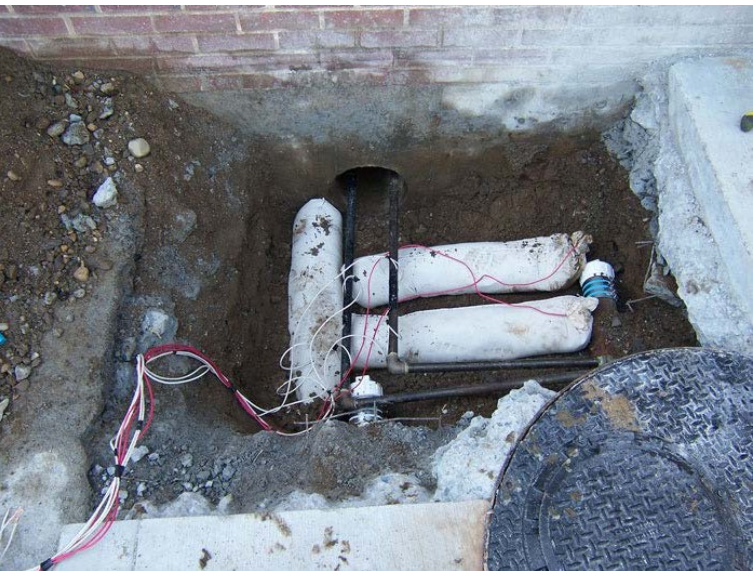
连接到金属管道的袋式阳极
