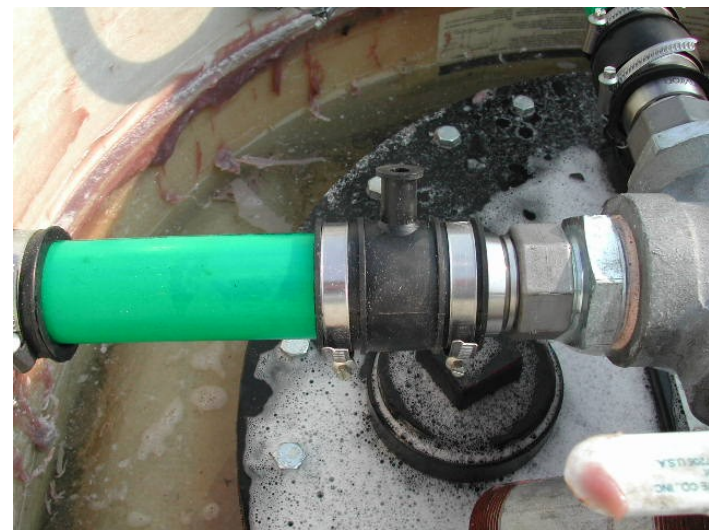
带检测保护套的双 壁管道
