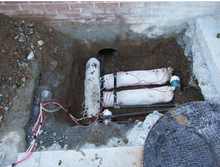
Anode túi được gắn vào đường ống kim loại
