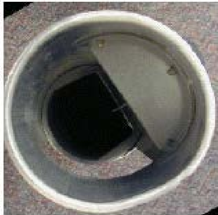
Nhìn Xuống Đáy Của Thiết Bị Tự Động Ngắt
