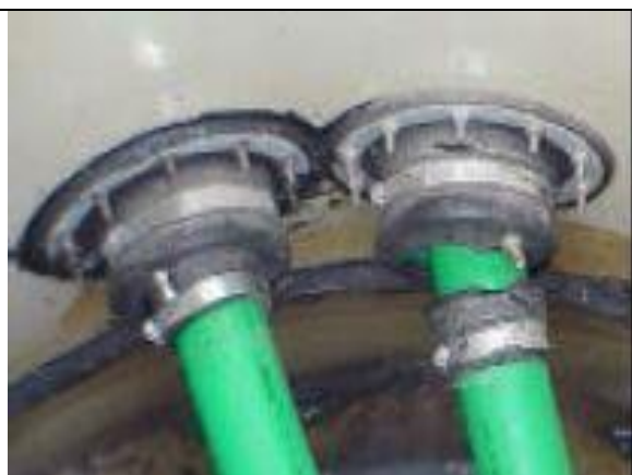
2. Nắp bịt Kiểm thử Environ Geo-Flex được gắn vào phụ kiện bịt kín; nắp bịt kiểm thử ở bên phải
