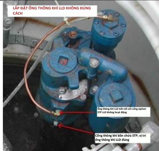
Lắp đặt ống thông khí MLLD không đúng (cổng siphon trên); MLLD không hoạt động.
