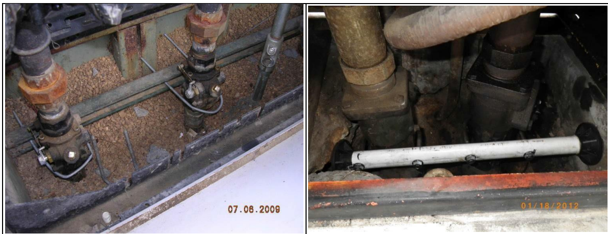
Trên đây là những ví dụ về van ngắt được cố định không đúng cách:
