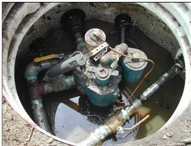
Nước và sản phẩm trong bể gom, cảm biến đã bị chuyển khỏi vị trí và không thể phát hiện chính xác chất lỏng trong bể gom
