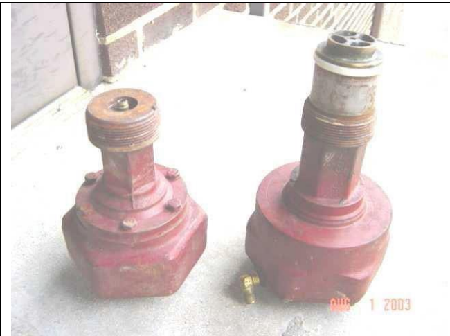
DLD Red Jacket với bộ lọc đầu thu và chốt đo được tháo ra ở hình bên trái
