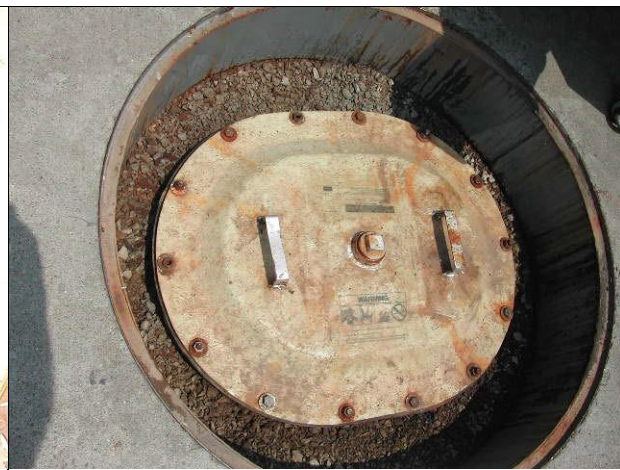
Bể gom bồn chứa hình bầu dục ở trên nóc bồn chứa bằng nhựa gia cố sợi thủy tinh (FRP)
