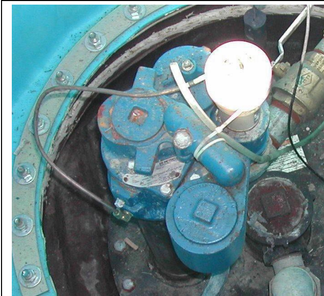
Lắp đặt đúng ống thông khí MLLD trên máy bơm chìm FE Petro (cổng ở đáy bồn chứa).
