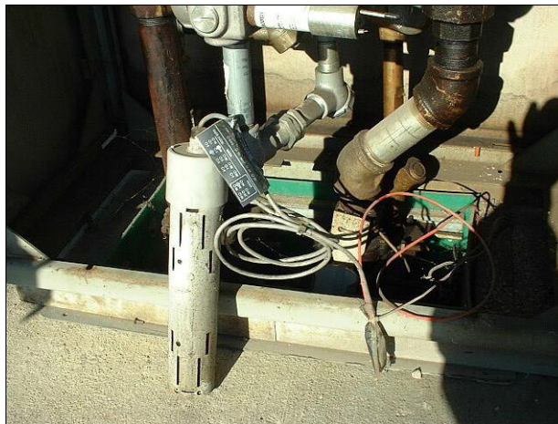
Bể gom Bên dưới Trụ bơm Nông có lắp Cảm biến
