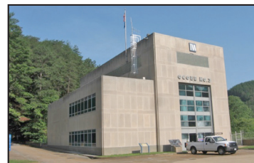
Ocoee No. 3 Dam.
